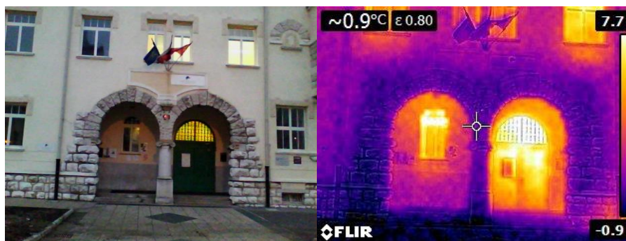
Slika: Vhod na šolo in termografska analiza
